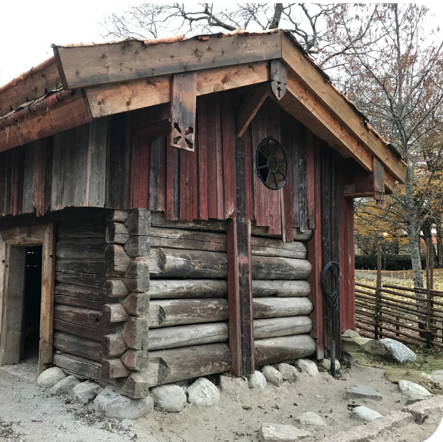
Örebro kommun, stuga av återbrukat virke.
