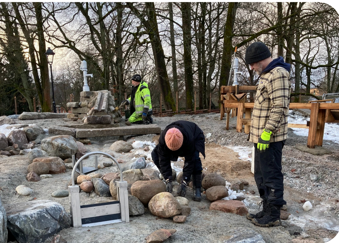
Örebro kommun, platsbyggd vattenlek med återbrukad sten.
