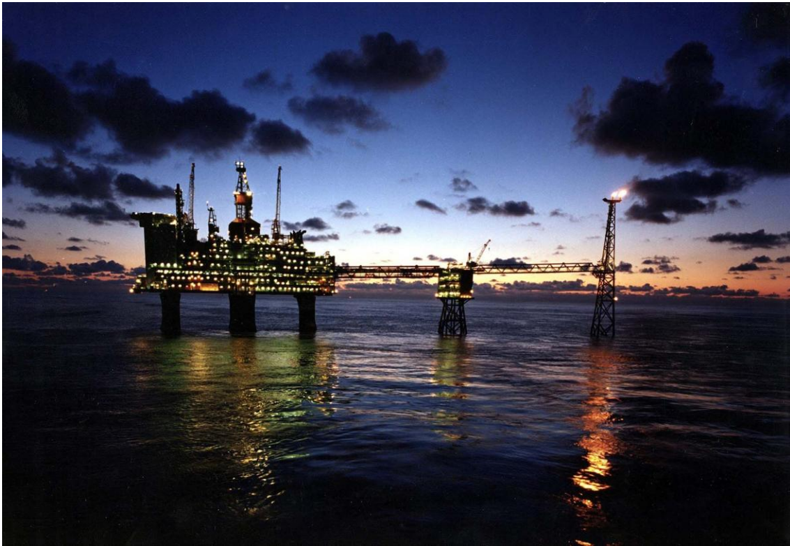
Bild 9. Statoils plattform Sleipner A. Foto Øyvind Hagen/Statoil.
